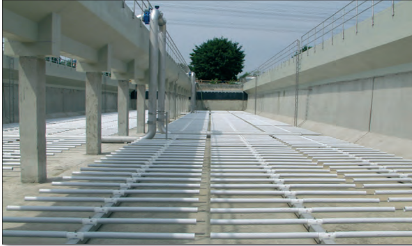
TANQUE DE LODOS ACTIVADOS: AIREADO CON DIFUSOR TUBULAR DE MEMBRANA MAGNUM® 2000 FLEXSIL®
